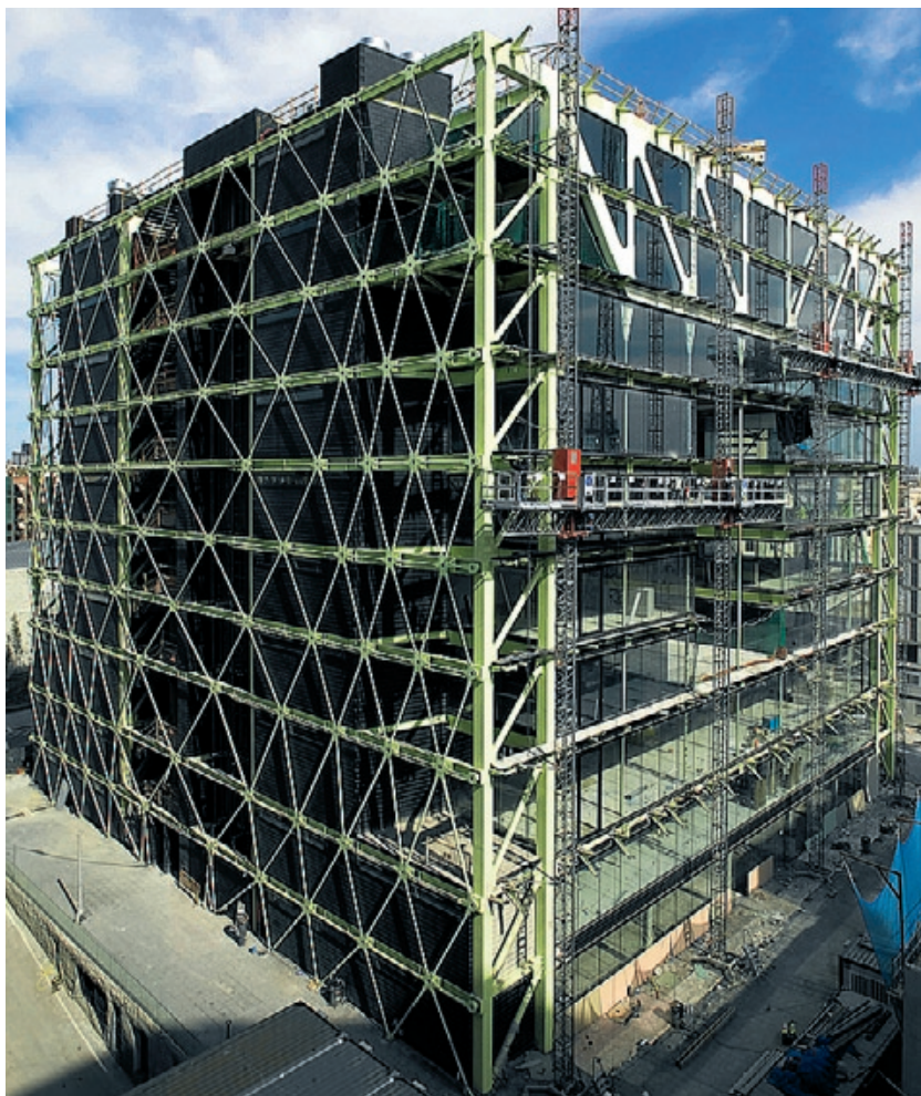
El edificio Mediativ del 22@, cuya inauguración está prevista en enero.
